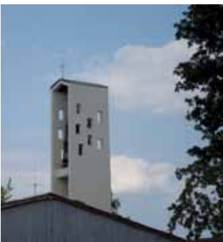
Christuskirche Altenfurt mit Glockenturm
